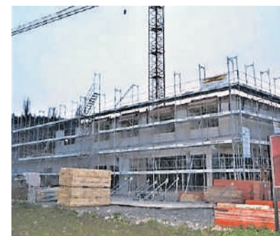
Der Rohbau ist noch im Gang. MEB
