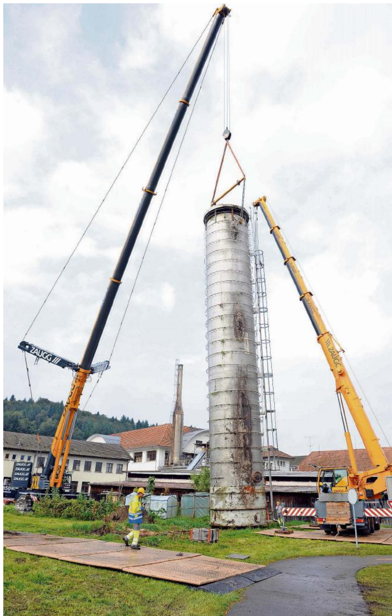
Ein Mega-Kran transportierte den tonnenschweren Schichtenspeichertank an seinen neuen Bestimmungsort.
